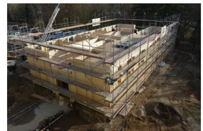
Rund 1.000 Kubikmeter Holz werden zur Errichtung der Wände, Decken, Treppen und sogar des Aufzugschachtes verwendet. Foto: Senckenberg/Tränkner
