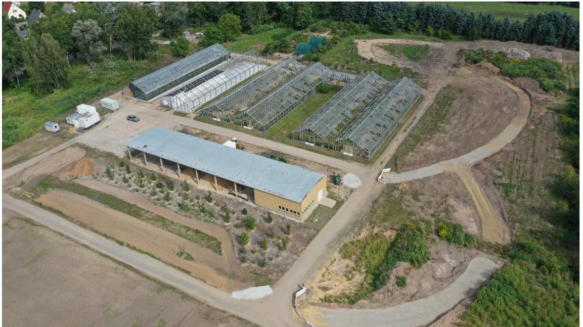
Luftaufnahme der neuen Branitzer Baumuniversität mit Agroforst, Gewächshäuser, Lebendsammlung © SFPM
