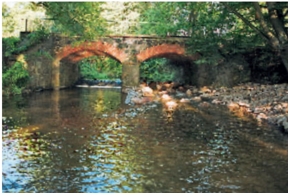
34. Wehr Telschow nach dem Umbau mit Sohlrampe in aufgelöster Bauweise
